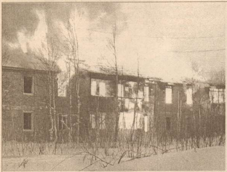
Нежилые дома создают угрозу пожаров
